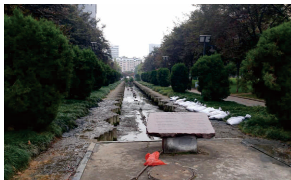
回溪公园人民西路路口改造前
