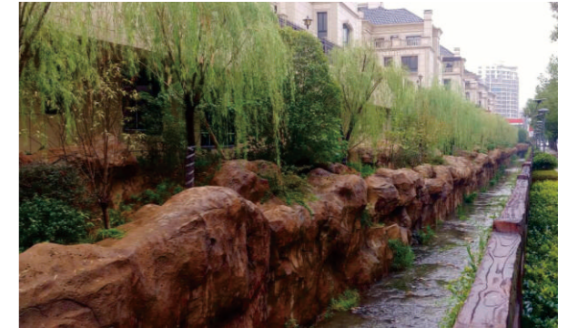
回溪盛世珑城段改造后
