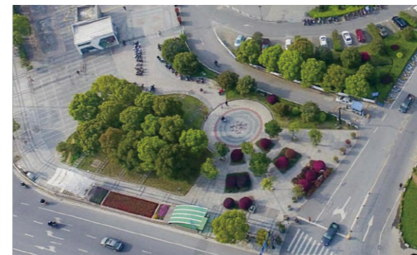
江北节点汇金国际改造前
